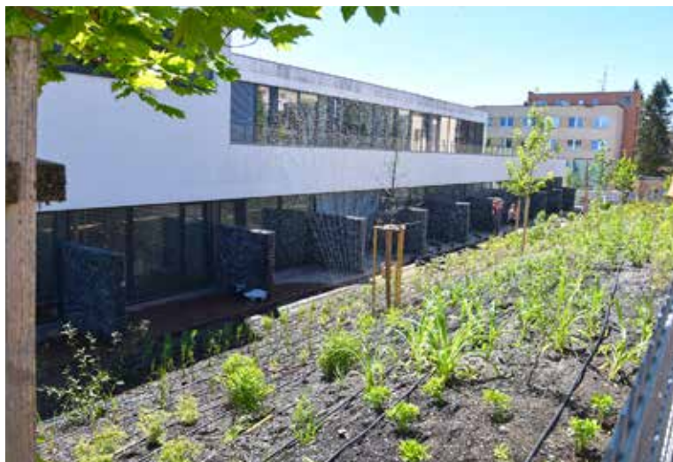
NA ÚPRAVÁCH SE ZAČALO JIŽ V DUBNU pokládkou závlahového systému. Od května již zahradníci sází zeleň kolem celé rehabilitace. Foto: Markéta Zikmundová
