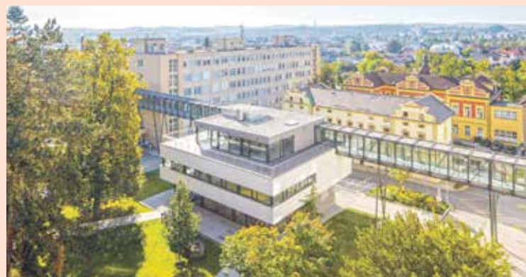
CENTRÁLNÍ VSTUPNÍ PAVILON vznikl v parku a je těžištěm celého areálu. Prosklený koridor v korunách stromů je navíc malou vnitřní kolonádou.
