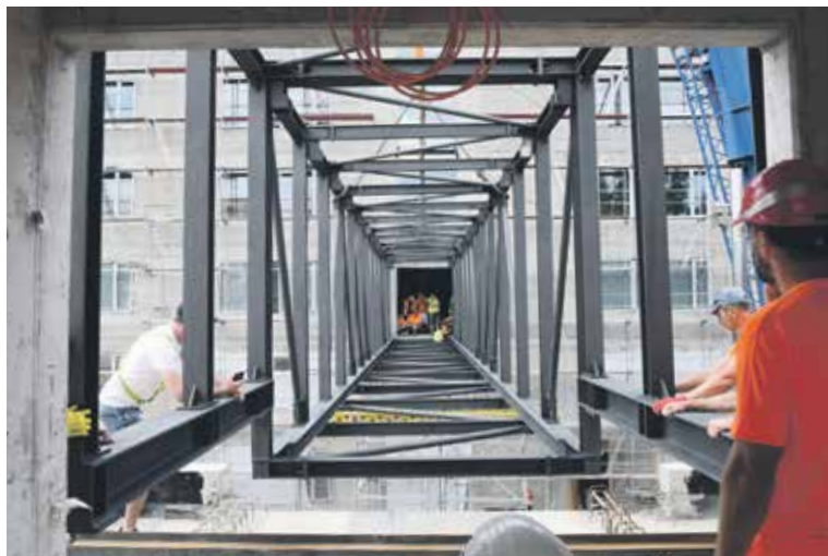
V ČERVNU DOŠLO K VYZVEDNUTÍ jedné části nadzemního koridoru od přístavby chirurgie. Nová „lávka“ z ocelových profilů je dlouhá 26 metrů a váží 17 tun.
