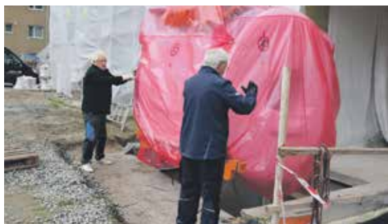
PŘIPRAVENÝM OTVOREM byla magnetická rezonance spuštěna do suterénu nové přístavby.
